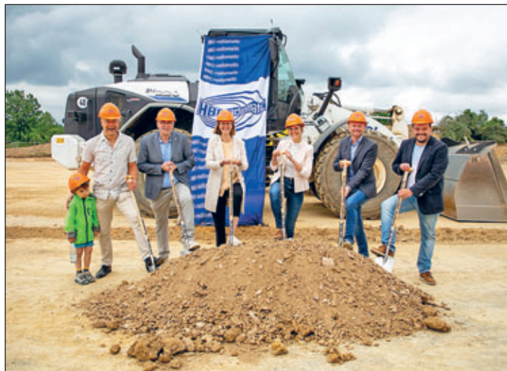
Foto vom Spatenstich am 16.06.2023
